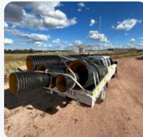
Blaxmax-Rohre wurden gesammelt, um als kleine Straßenübergänge verwendet zu werden.
