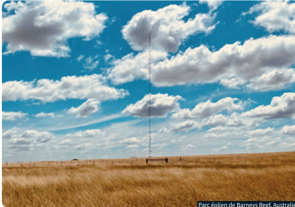
Parc éolien de Barneyes Reef, Australie
