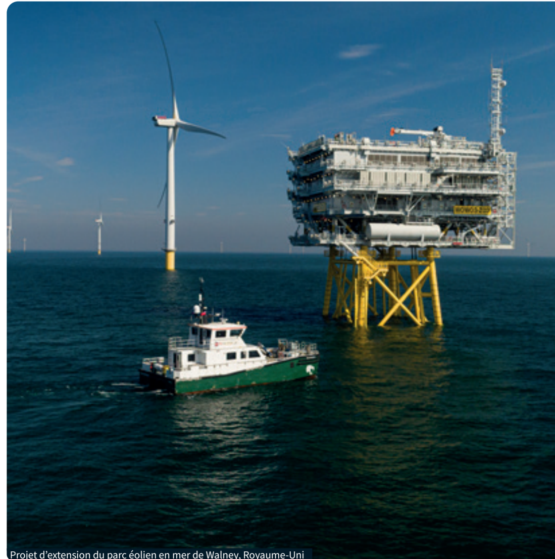
Projet d'extension du parc éolien en mer de Walney, Royaume-Uni
