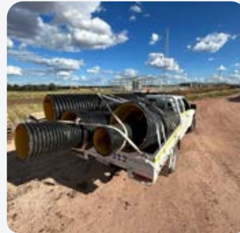
Blaxmax boruları küçük yol geçitleri olarak kullanılmak üzere toplandı.
